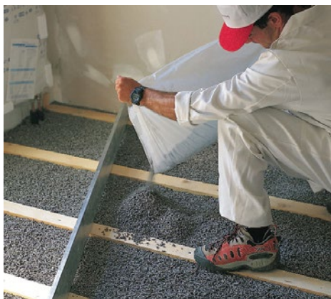
Mise en place de matériau absorbant en vrac © Thermofloc
